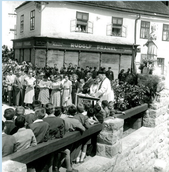
Sierningbachregulierung 1950 - 51 Johannesstatue - Sanierung 08. Juli 1951
