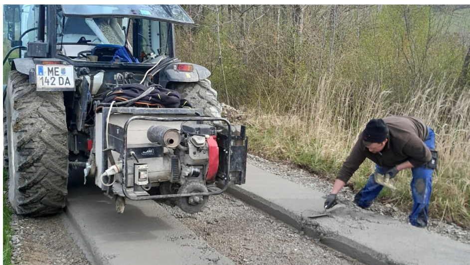
Errichtung eines Spurweges am Kuhberg
