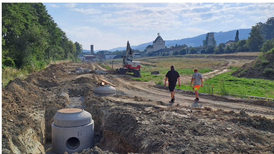
Arbeiten im Betriebsgebiet gehen Schritt für Schritt voran
